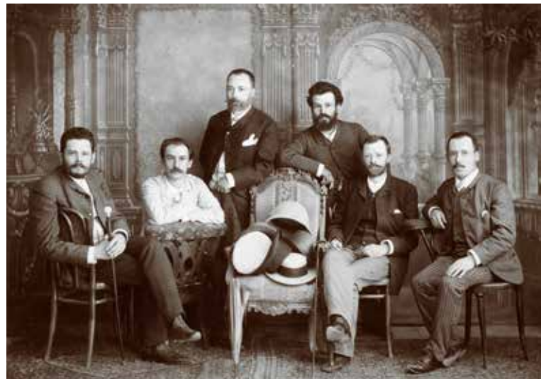
15-летний юбилей строительной конторы: С. П. Гагрилов, Г. М. Фарбитейн, А. В. Бари? (слева), В. Г. Шухов (второй справа). 1895
