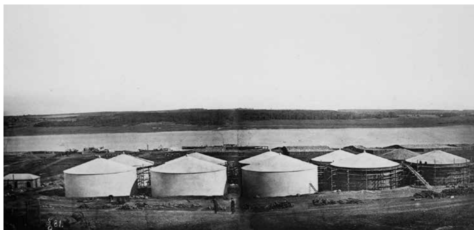
Рис. 6. Нефтяная станция в Константиново на Волге. Емкость резервуаров 20 208 000 л. Снимок от 5 сентября 1881 года из альбома фотографий строительства резервуаров фирмы А. В. Бари (Архив РАН. Ф. 1508. Оп. 1. Д. 1. Л. 4)
