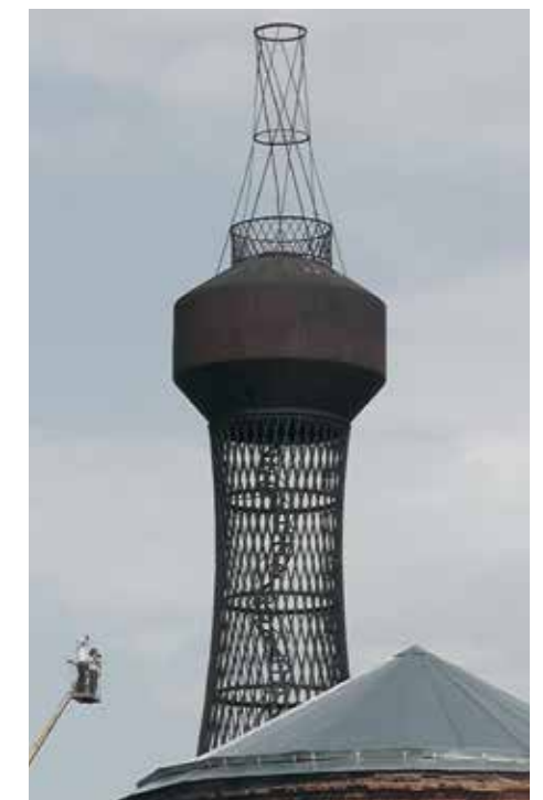
Рис. 273. Водонапорная башня в Полибине. Малая гиперболическая башня на резервуаре (фотография Сергея Арсеньева, 2012)
